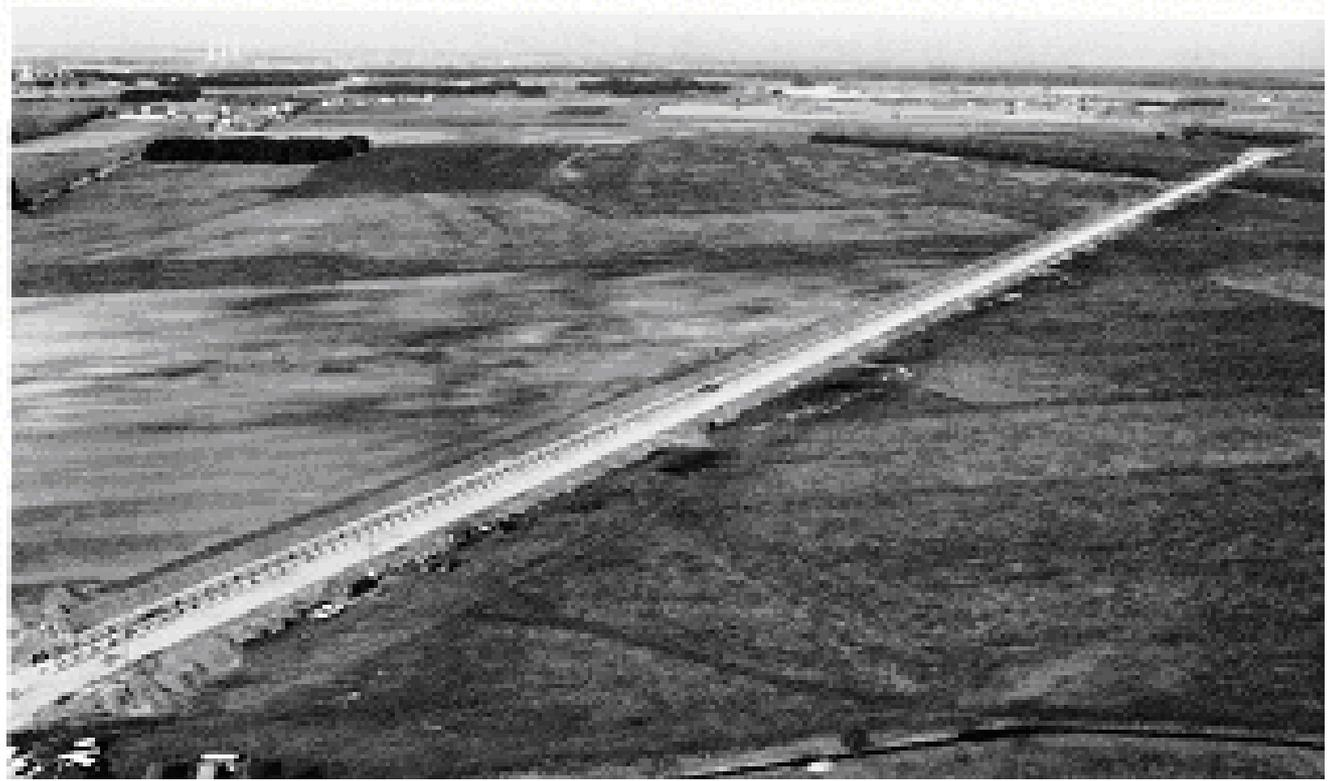
➤ 1974/75: Inbetriebnahme des Komponentenmeßträgers KOMET von MBB (keine Sitzplätze, 401.3 km/h, Asynchron-Kurzstator-Linearmotor)
