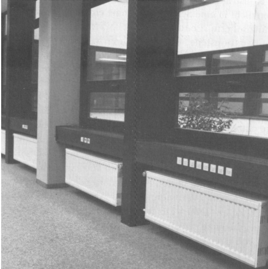
Installationskanäle für Wand- und Brüstungs-Installation werden aus flammwidrigem Kunststoff oder Stahlblech mit Kunststoff – Deckel mit mehreren, verstellbaren Fächern hergestellt, so daß Leitungen mit verschiedenen Spannungen und Funktionen getrennt verlegt werden können. Es sind Kanalgrößen z. B. mit 133, 173 und 213 mm Höhe, 63 mm Tiefe und — 2 m Länge lieferbar.
