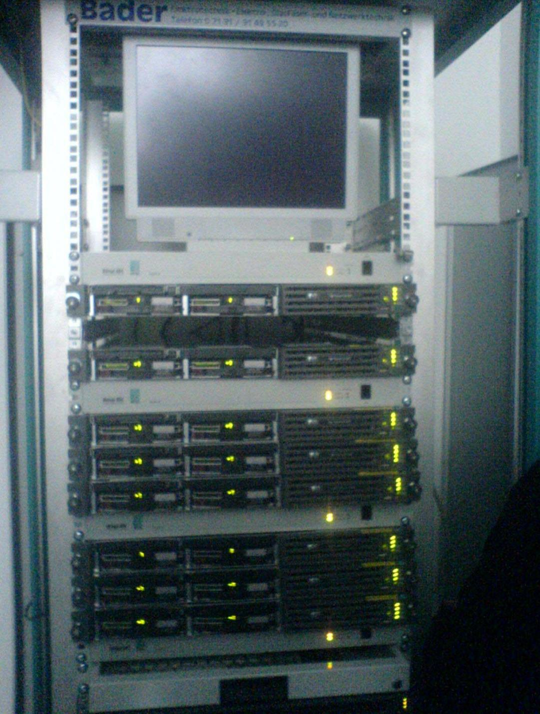
Rechnerzentrale der 6 OPC-Server und des Leittechnikrechners
