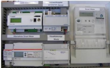
Das installierte System misst über einen eHz der Firma Lingg&Janke den Energieverbrauch und die aktuelle Leistung des Gebäudes.
