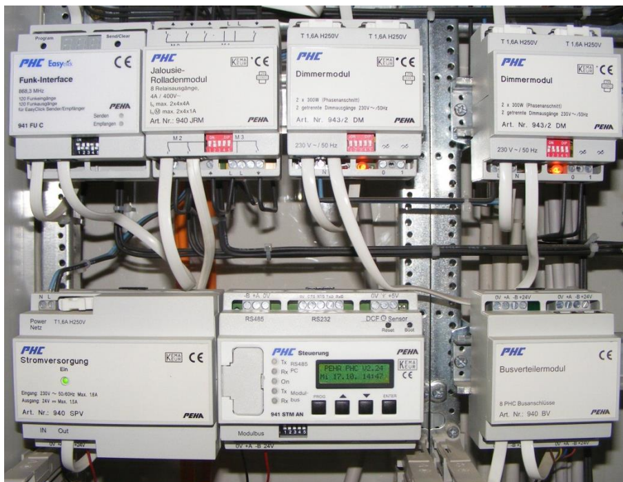
Abb. Fehler! Kein Text mit angegebener Formatvorlage im Dokument..1 Peha PHC-Systemaufbau
