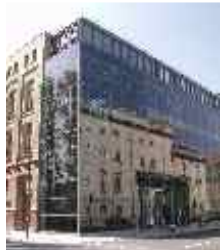
Unterirdisches Erschließungssystem (UES) Neue Regierungsbauten/Reichstagsgebäude Berlin/Germany
