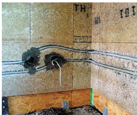
Die Elektroinstallation musste in die Heraklit-Dämmplatten eingearbeitet werden.
