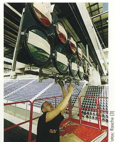
Bild 3: Montage der Verkehrs-Signalampeln
