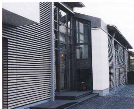
Das Wohnhaus des Firmengründers Tobias Groten dient als Referenzanlage für die neueste Entwicklung des Unternehmens
