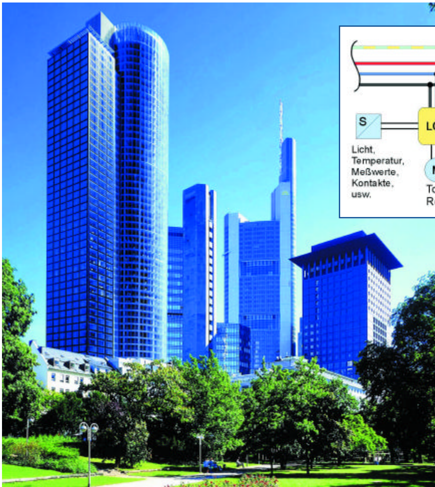
Der Maintower kann mit Europas umfangreichster Installationsbusanlage in einem Einzelgebäude aufwarten
