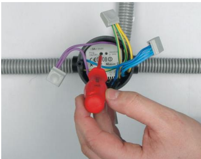
Abb. Fehler! Kein Text mit angegebener Formatvorlage im Dokument..27 Programmierung bei xComfort im Basic Mode [EATON]
