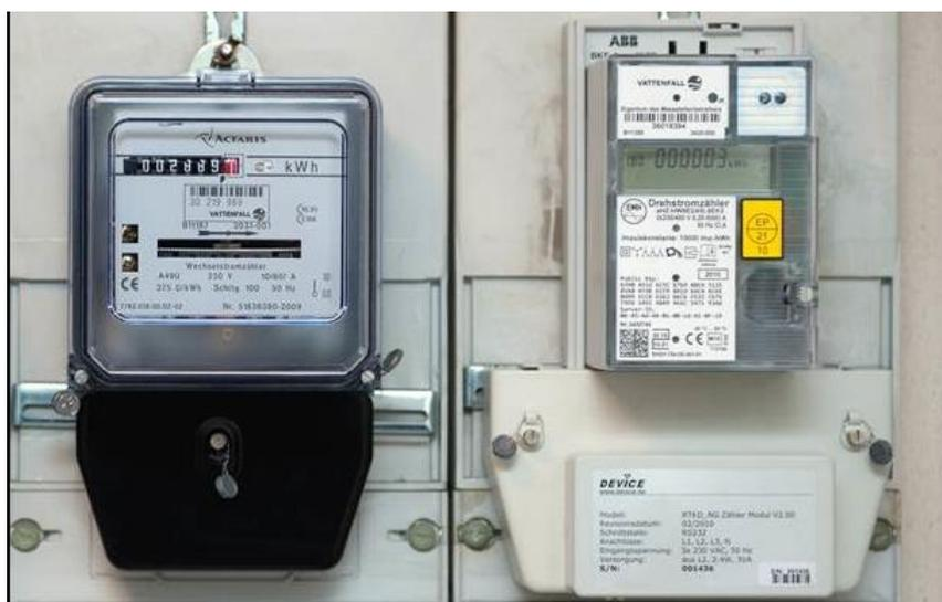
Abbildung 1 Smart Meter<sup>1</sup>
