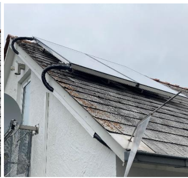
Abbildungen: Solarrohrverlegung
