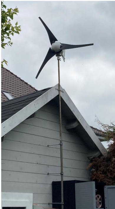
Abbildung: Klein-Windkraftanlagen
