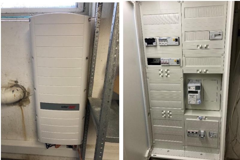
Abbildung: Aufbau von Wechselrichter, Batteriespeicher und Netzanschluß
