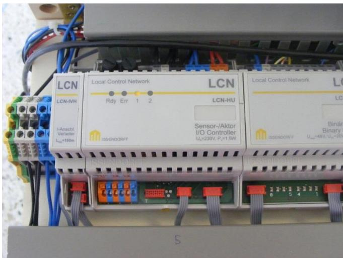
**Abb. Fehler! Kein Text mit angegebener Formatvorlage im Dokument..5 LCN-Modul mit angeschlossener Peripherie**
